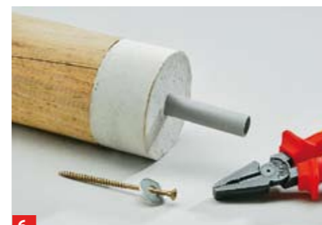
6 Ist der Beton ausgehärtet, können Sie die Schalung lösen und das PVC-Rohr mit einer Zange herausziehen
