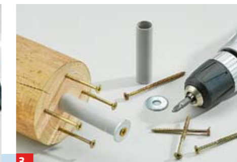
3 Schrauben dienen als Armierung: Sie halten den Betonsockel fest am Schaft – mittig fixieren Sie ein PVC-Rohr
